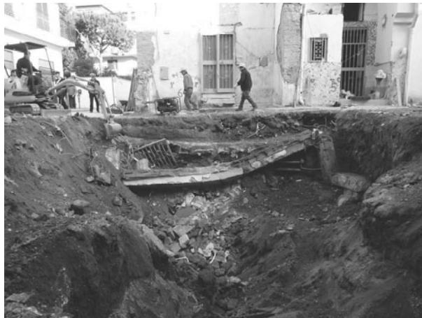
**Figura 5.** Ritrovamento di elementi in c.a. delle strutture crollate.
