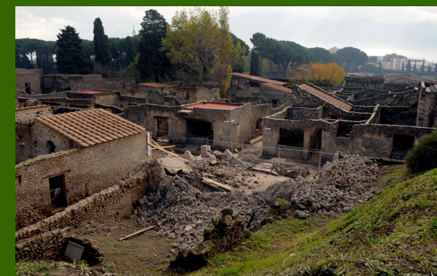
Crollo della Schola Armaturarum di Pompei
